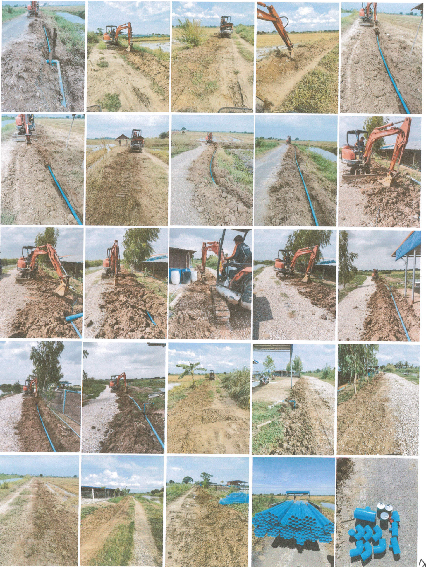
ภาพถ่ายประกอบการดำเนินการจ้างเหมาวางท่อประปา ขนาด ๒ นิ้ว ชั้น ๘.๕ ระยะทางยาว ๖๓๐ เมตร บริเวณถึงประปาบ้านเกาะ หมู่ที่ ๓ ถึงกลุ่มบ้านนางสาววีณา วงษ์คล้าย
